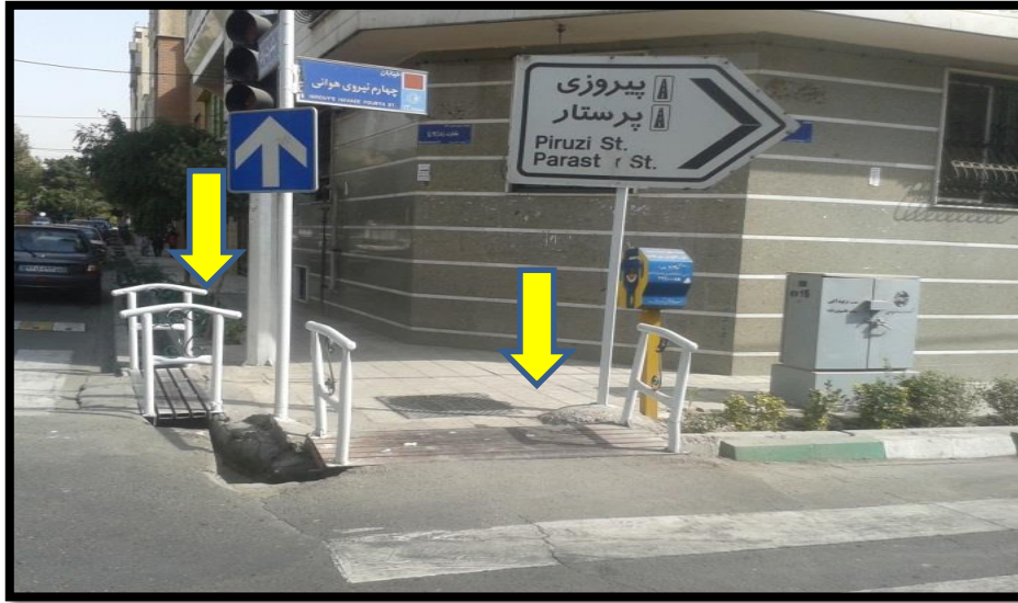
شکل ۲: نمایی از پل‌های احداث شده با دستک محافظ
